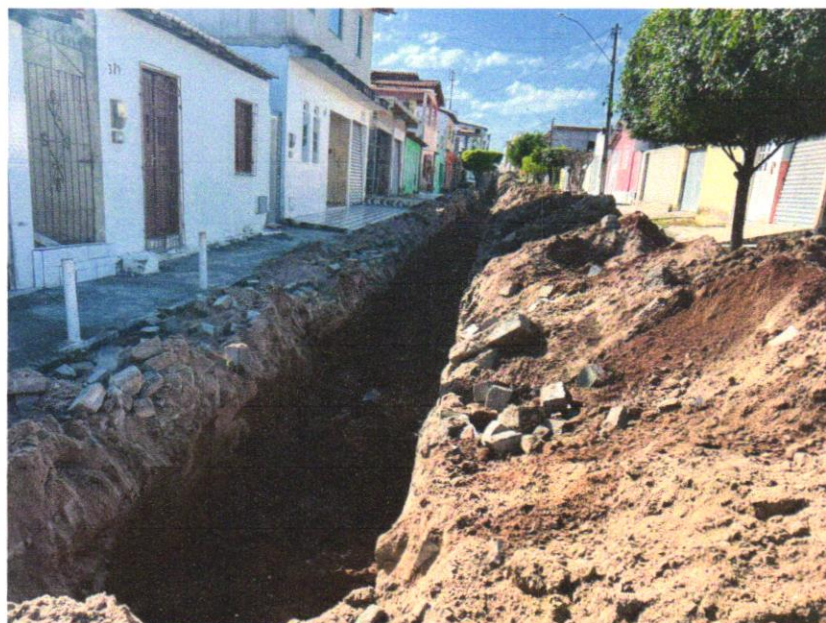
Foto 02 – ESCAVAÇÃO DE VALA
