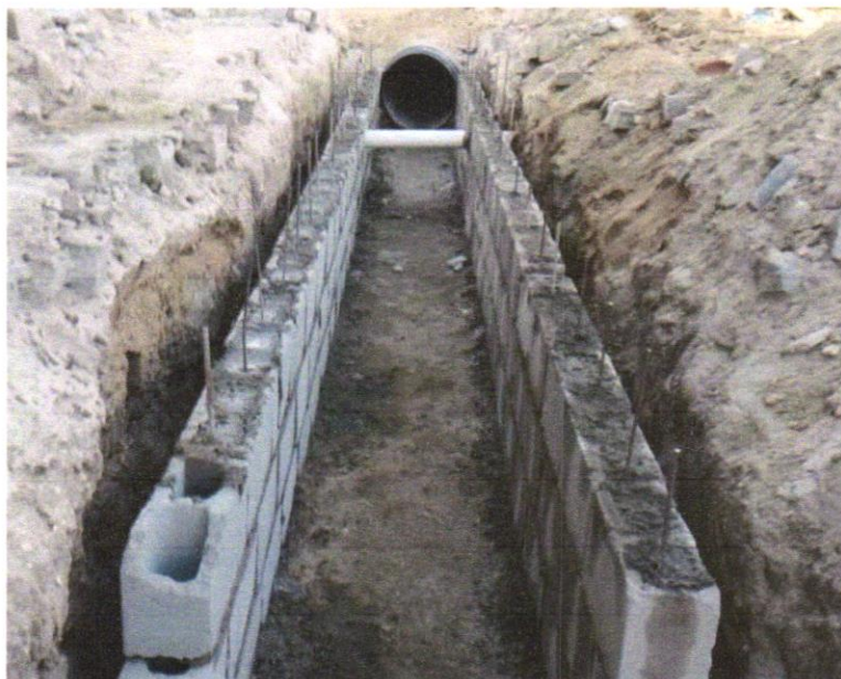
Foto 04 - ALVENARIA DE BLOCOS DE CONCRETO ESTRUTURAL 14X19X39 CM, (ESPESSURA 14 CM) FBK = 14,0 MPA, PARA PAREDES COM ÁREA LÍQUIDA MENOR QUE 6M 2 , SEM VÃOS, UTILIZANDO PALHETA. AF_12/2014
